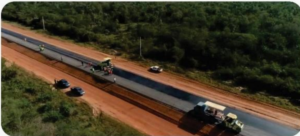
Pozo Colorado - Concepción
