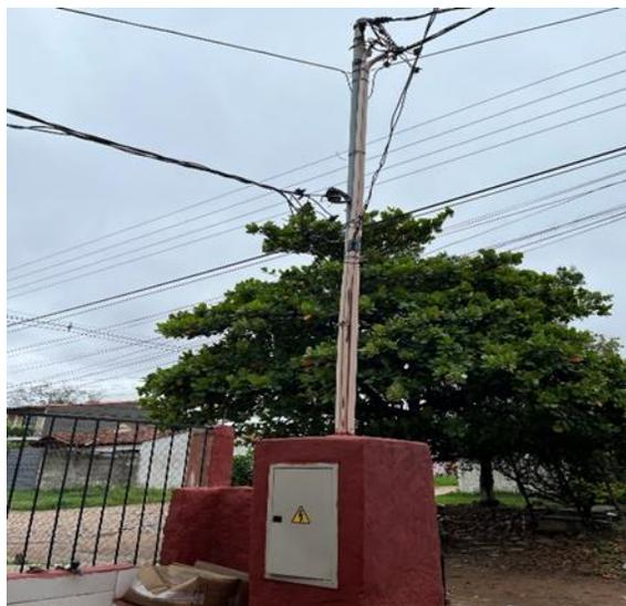
**Figura 10: Conexión monofásica, necesita ser reemplazada por trifásica para un suministro confiable. Colegio Nacional Tesape Ara, Central Guarambaré. Noviembre 16, 2022**
